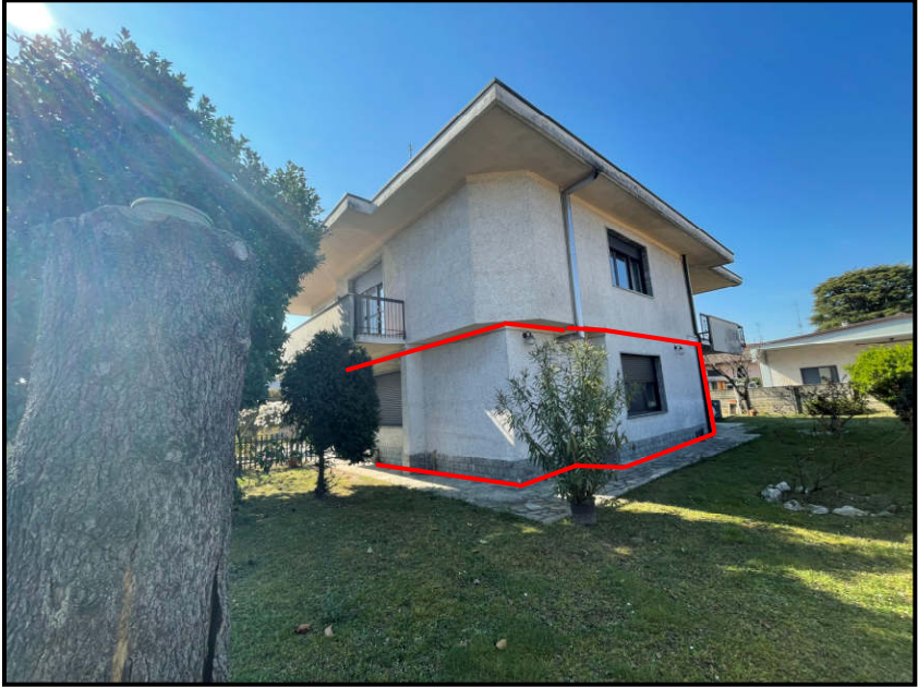
Vista da cortile interno prospetti nord ed est
